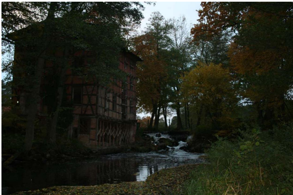
Fig. 19. Ruiny starego młyna i ruina jazu. w miejscowości Głębocek.
