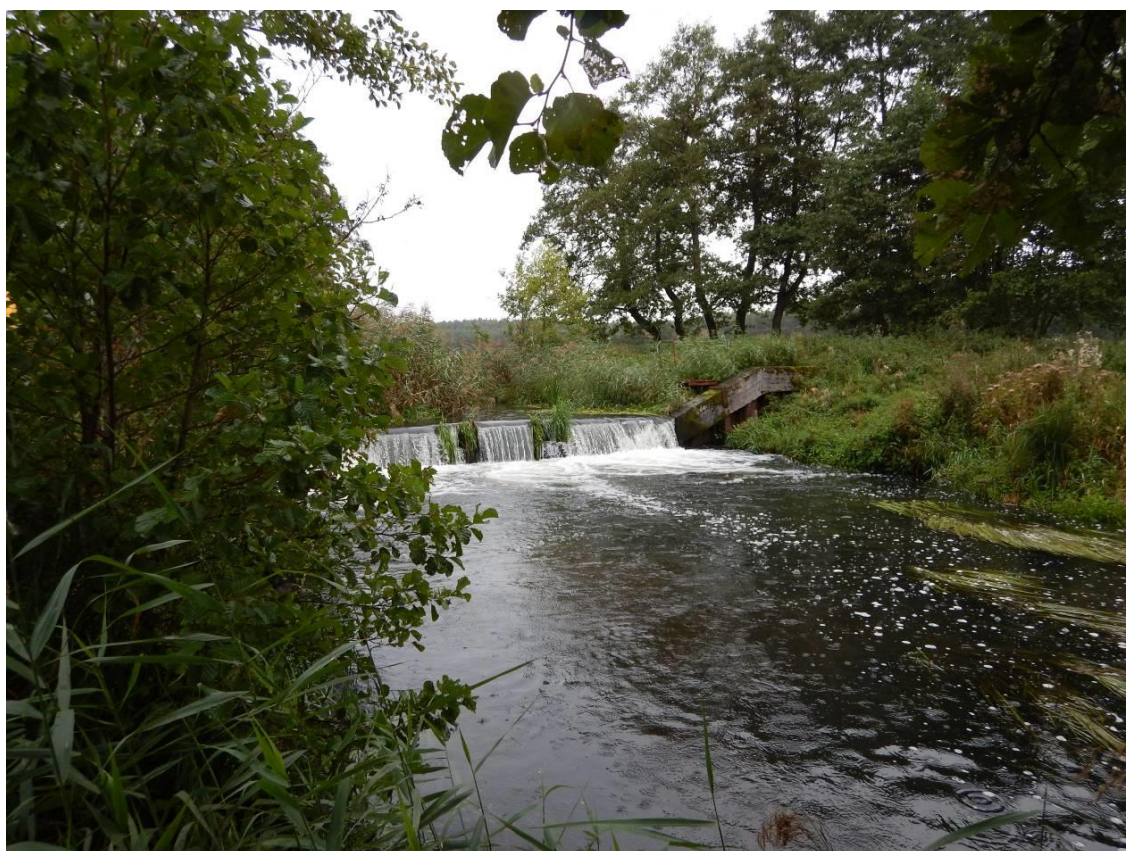
Fig. 10. Widok na stanowisko G9 i jaz piętrzący wodę dla gospodarstwa rybackiego.
