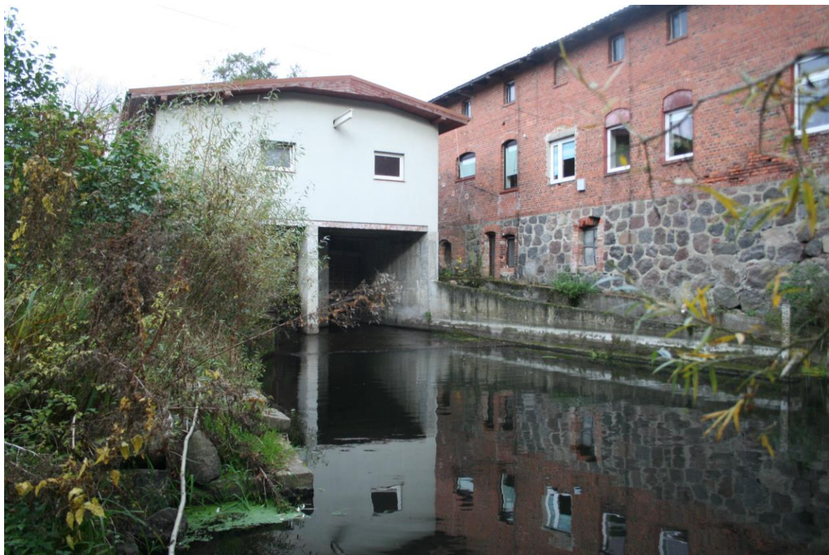
Fig. 18. Jaz piętrzący dla MEW w Drawsku Pomorskim przy ul. Kolešno i elektrownia od wody dolnej.
