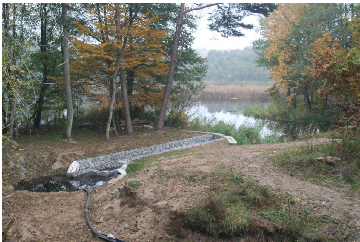
Fig. 20. Początek Starej Drawy - widok na zastawki od strony rzeki na jezioro oraz gabionowe obejście w trakcie budowy.
