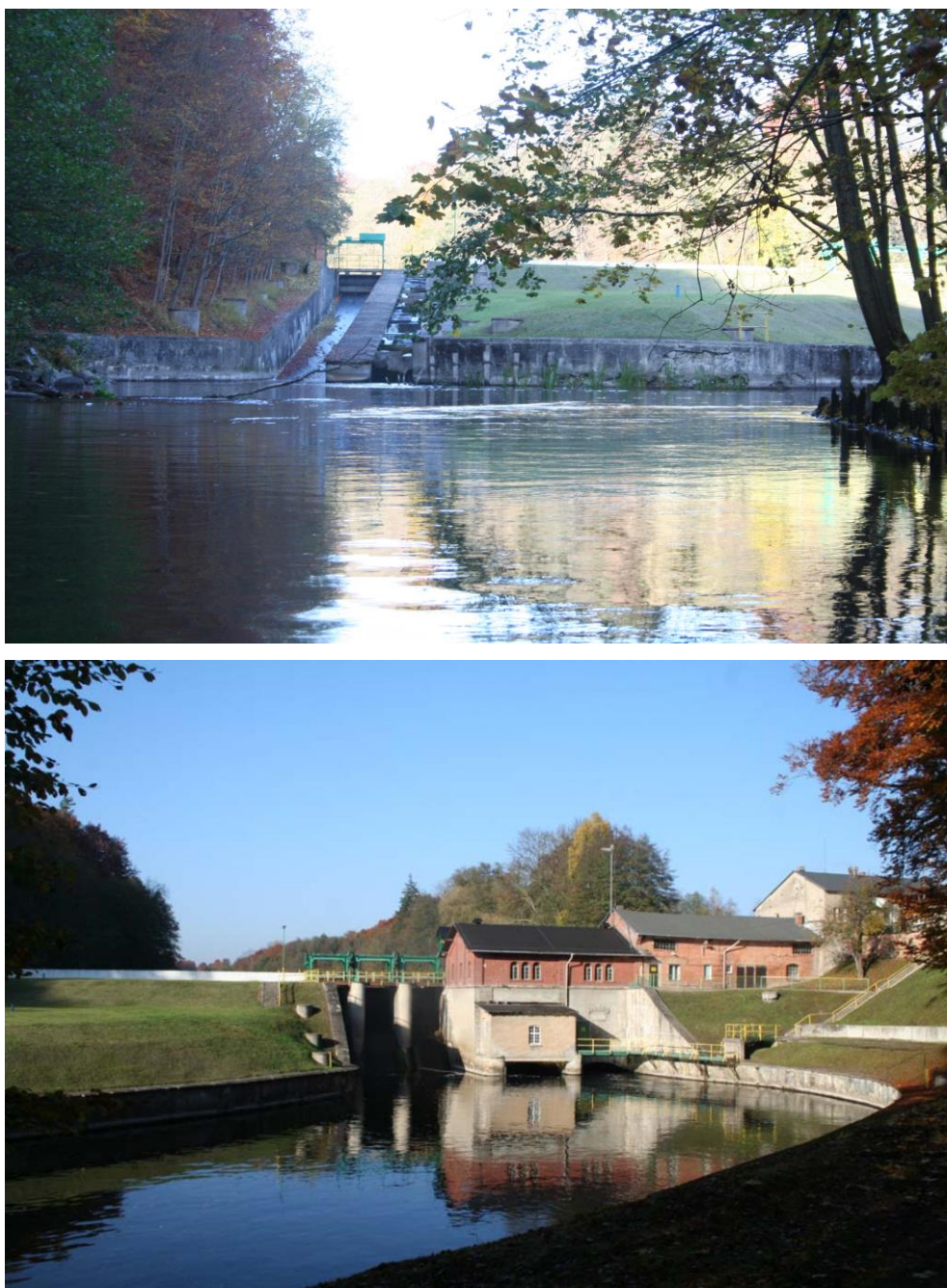
Fig. 17. Elektrownia Kamienna w Głusku. Widok na rampę do spławiania drewna i przepławkę.
